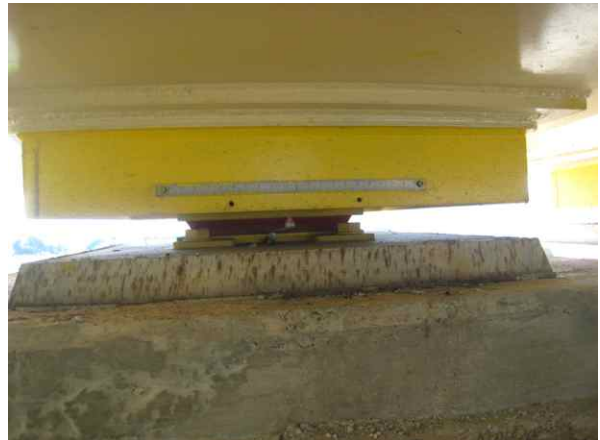
교량 받침 가동량 측정
