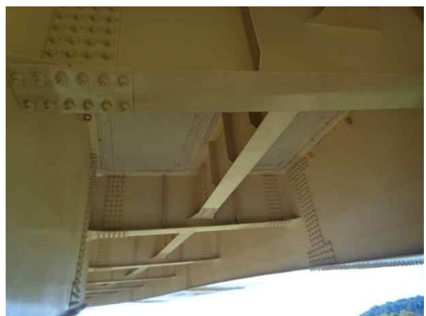
가로보 및 세로보 상태양호(STB)
