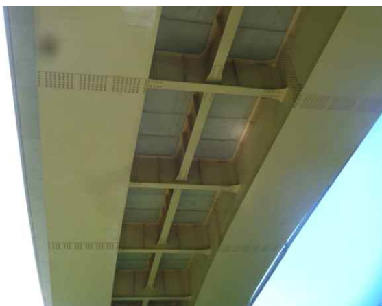
가로보 및 세로보 상태양호(STB)
